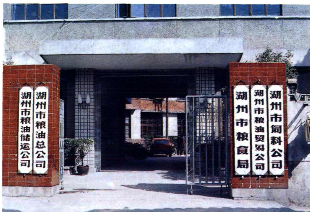
湖州市粮食局办公楼
