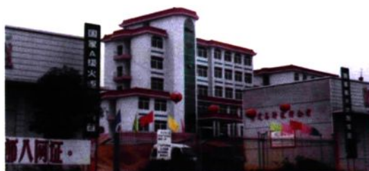
列入国家A级火炬计划项目的丰日电气集团有限公司办公大楼。
