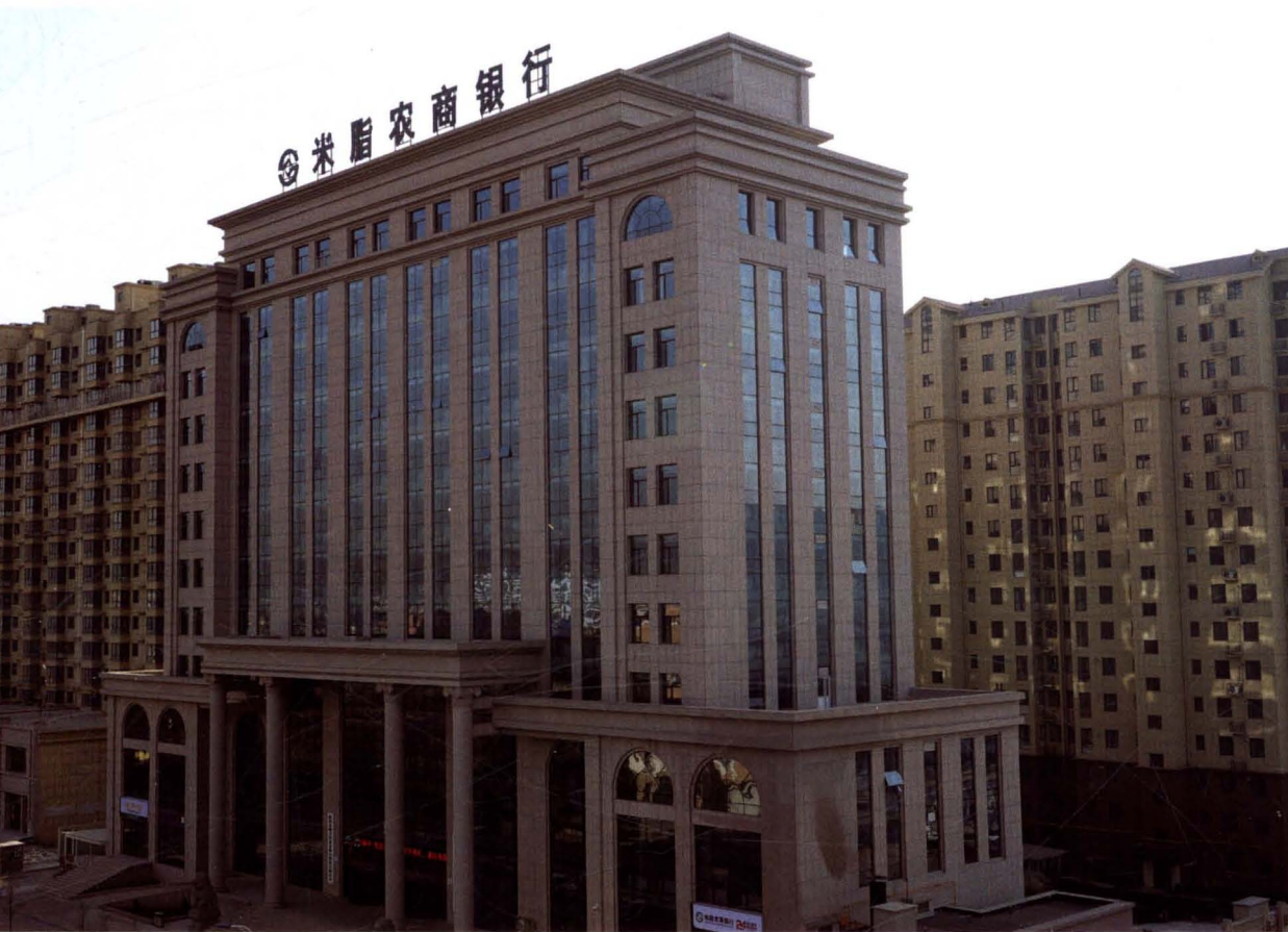
三农金融服务综合大楼及住宅楼
