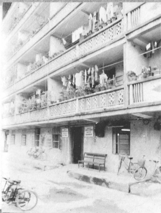
陆城镇温泉镇财政所综合办公楼
