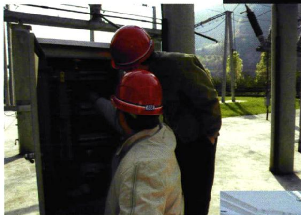
综合自动化改造后的升压站端子箱
