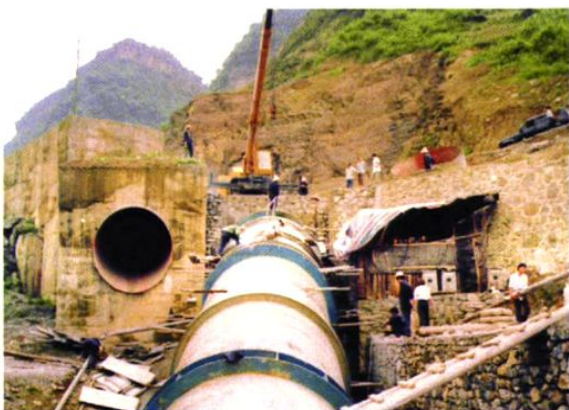
施工中的压力铜管
