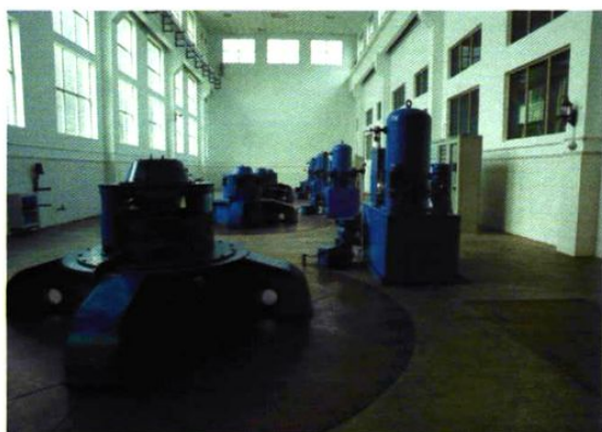
4台6300千瓦水轮发电机组
