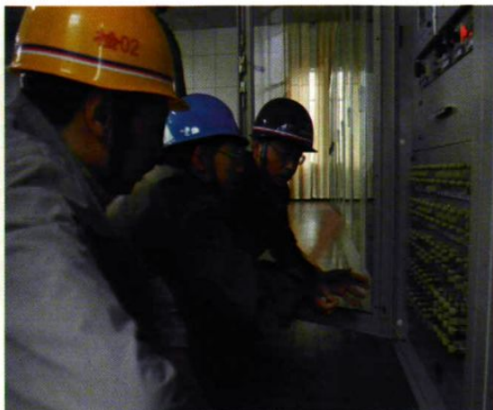
州总公司对天电进行安全检查
