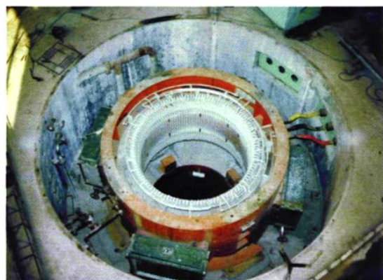
安装发电机转子
