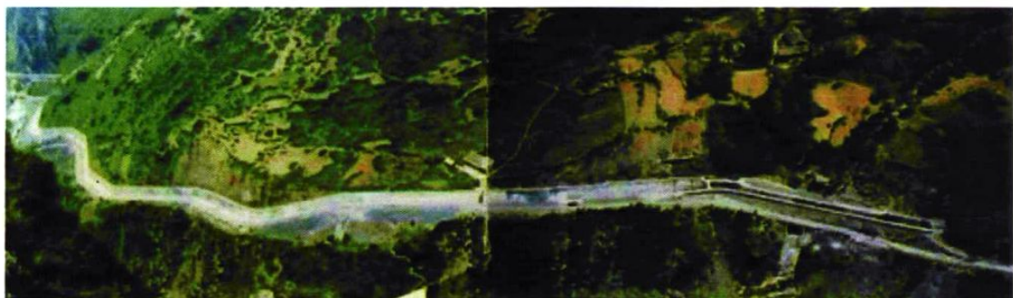
猪候坝段明渠地貌
