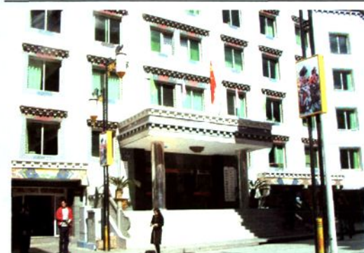
1997年修建的县委办公大楼
