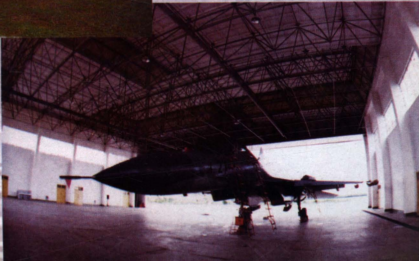
▼ 采用新材料建造的飞机地面库
