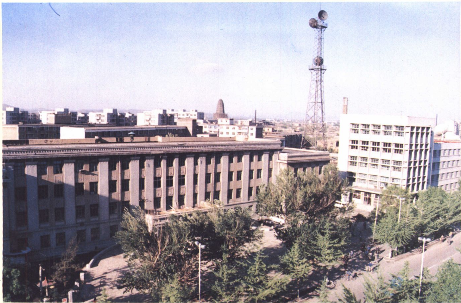
锦州局办公楼俯瞰
