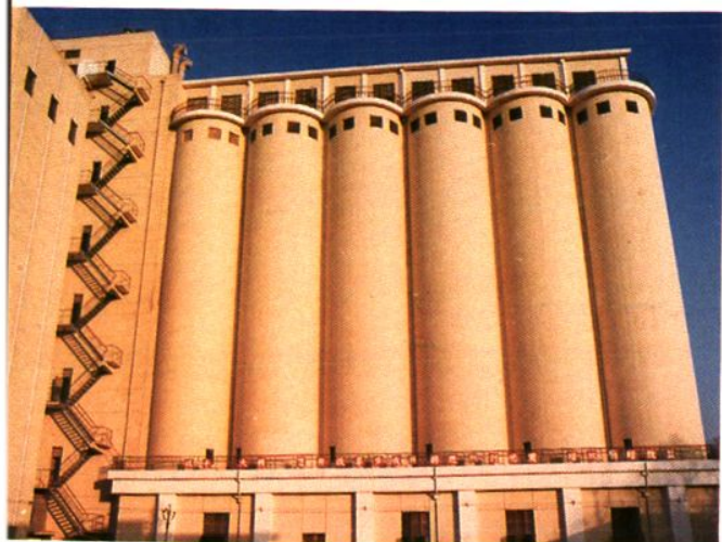
大型钢筋混凝土立筒仓
