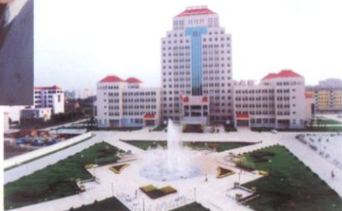
▲ 扬州大学校本部主体教学楼
