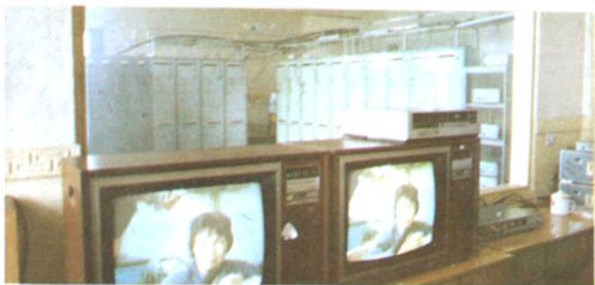
烟台电 视台塔山微 波机房
