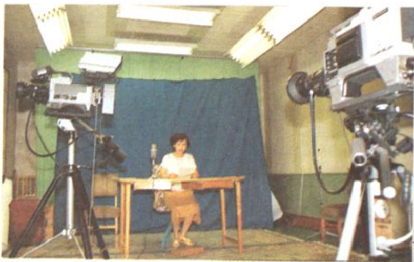
烟台电视台节目 制作中心机房（下）
