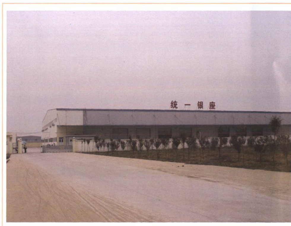
■ 统一银座生产仓储中心
