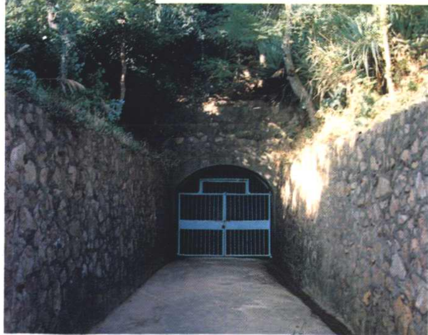
◀ 普陀山地下粮库口
