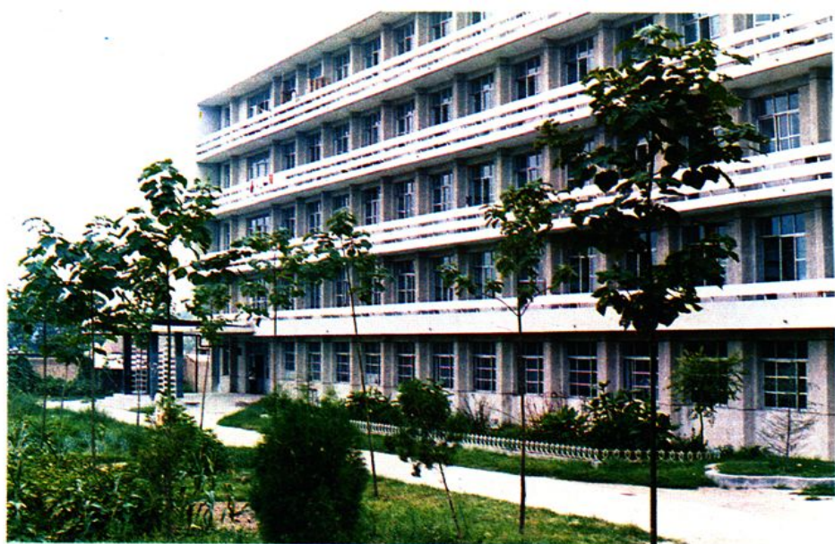
省、地财政投资兴建的地区中医院住院部。
