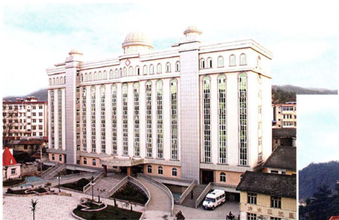
▲ 县医院住院部大楼
