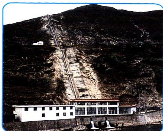
冻谷电站全景
