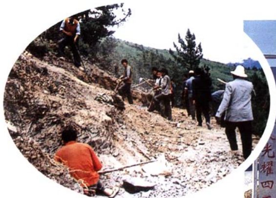
正在施工的日徐公路
