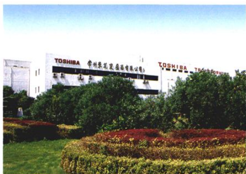
常州东芝变压器有限公司
