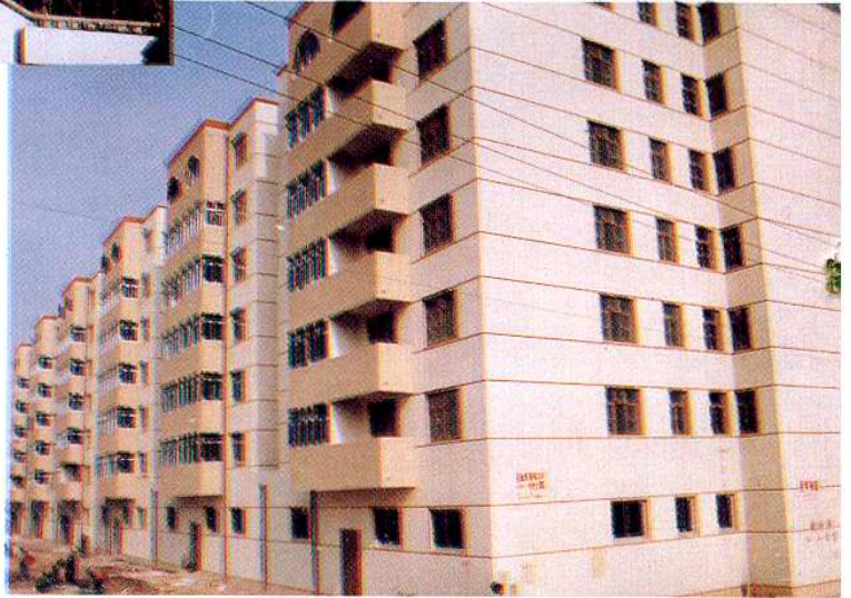
吉宁里住宅楼
