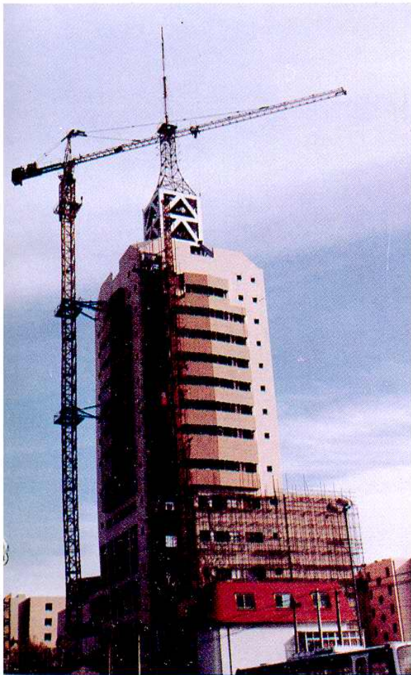
建设中的塘沽广播电视新闻中心
