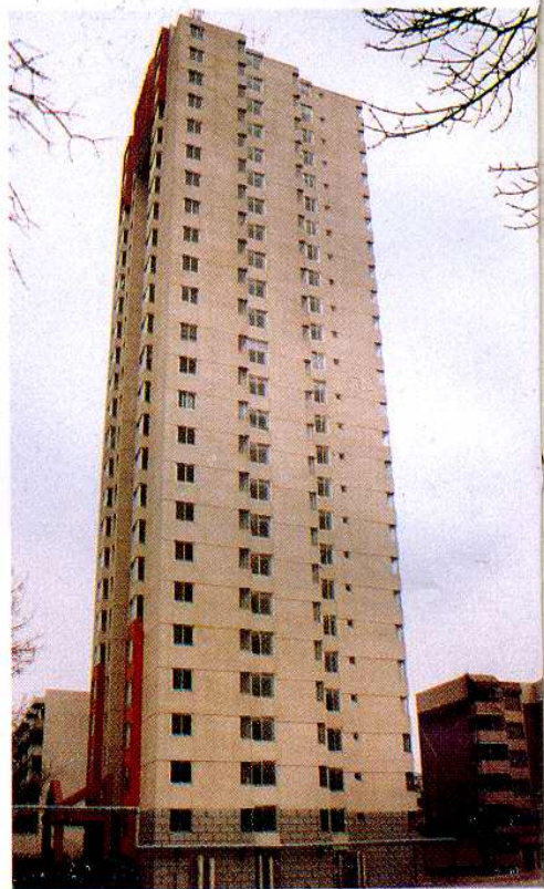
改造后的工人新村小区高层住宅
