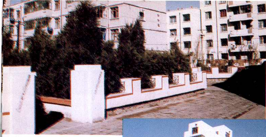
新港地区住宅楼
