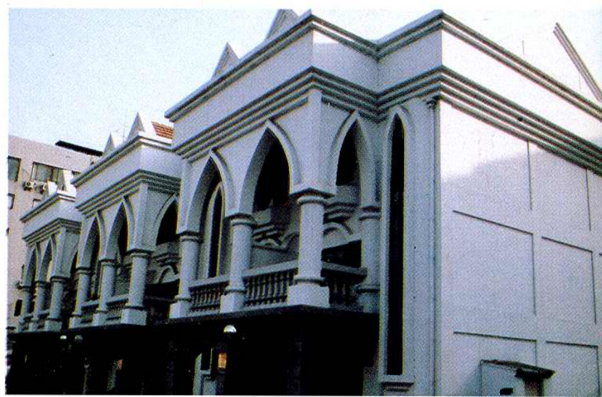
开发区办公楼和住宅楼
