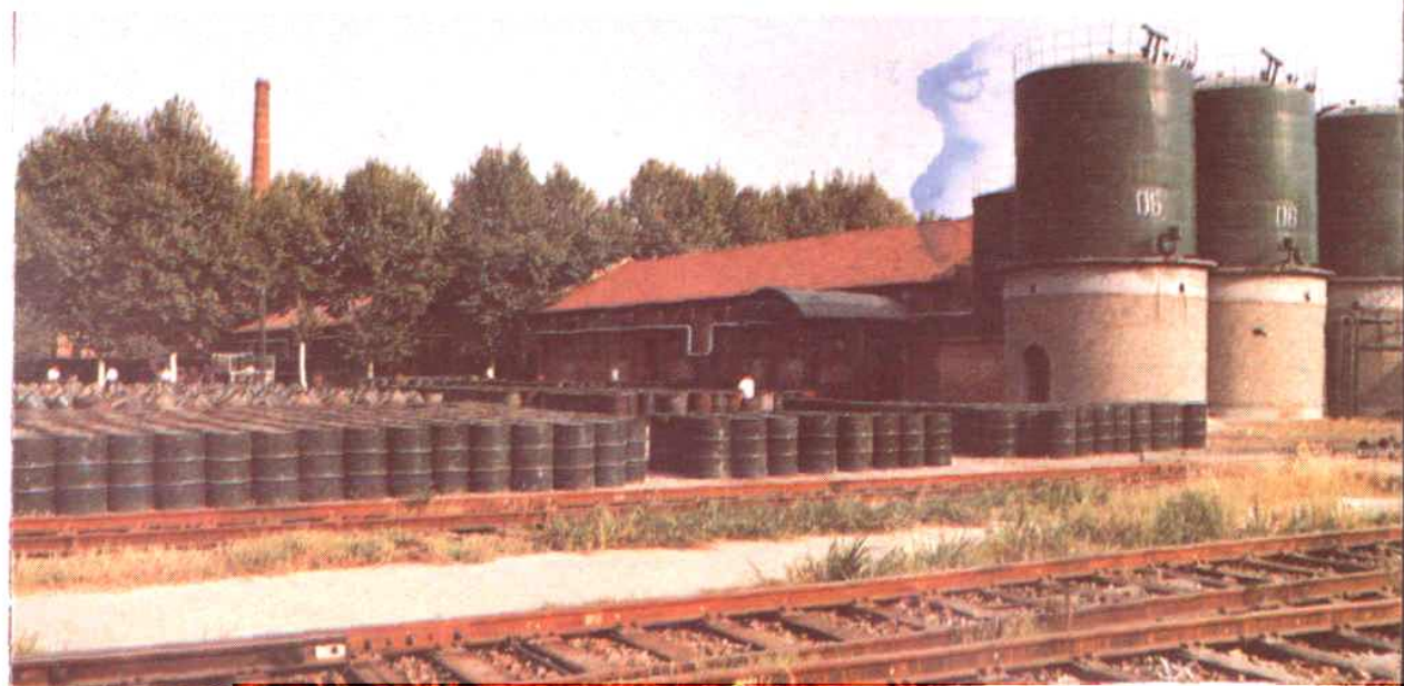
润滑油高架罐和桶装润滑油区
