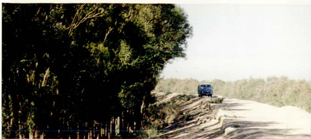
拦河闸上游防洪堤
