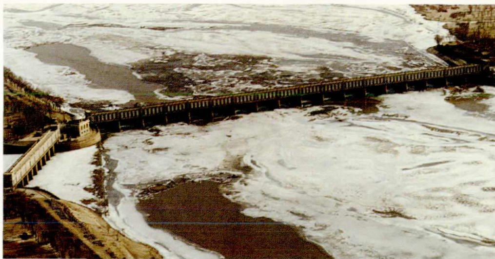
凌汛期拦 河闸全貌
