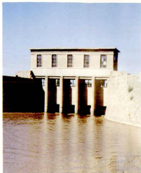
南岸干渠进水闸
