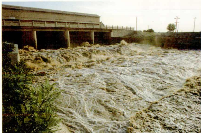
三盛公水电站跌水闸
