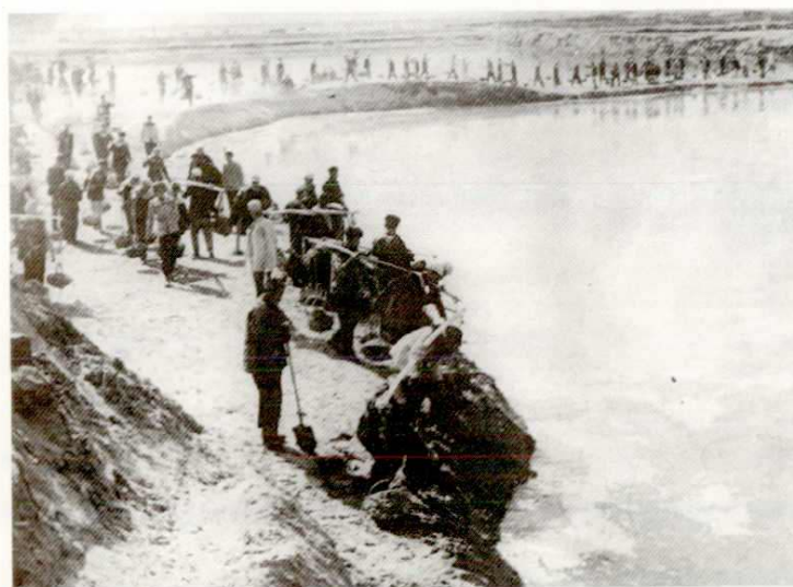
拦河闸截流工程施工现场
