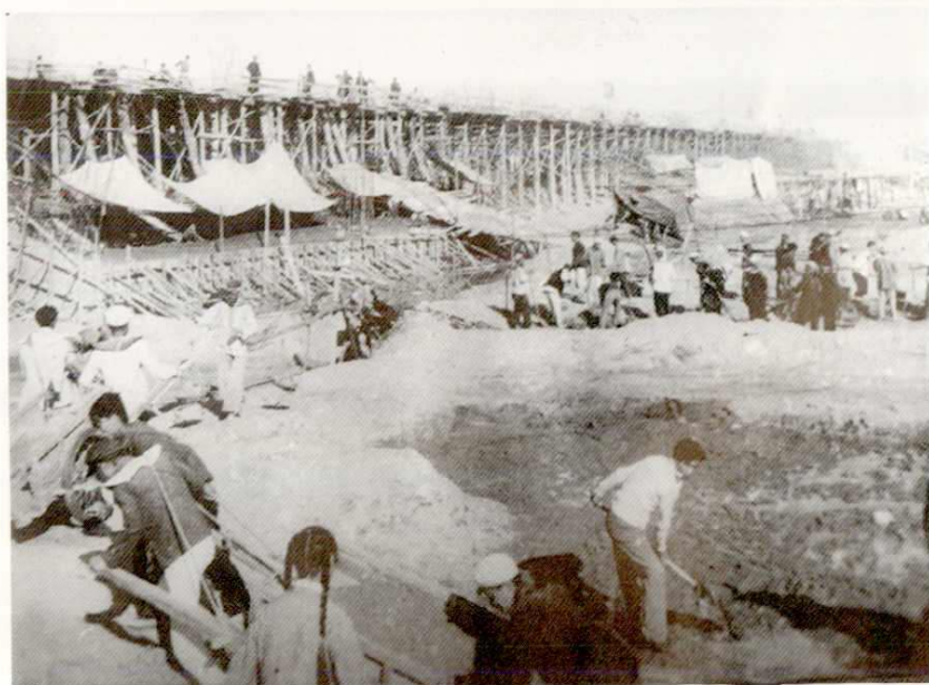
拦河闸闸底工程施工现场
