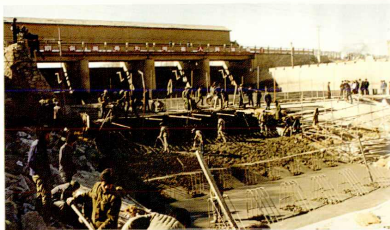
跌水闸消能防冲 加固工程施工现场
