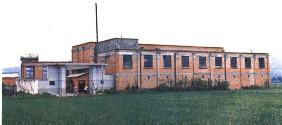
德和罐头厂富民分厂厂房
