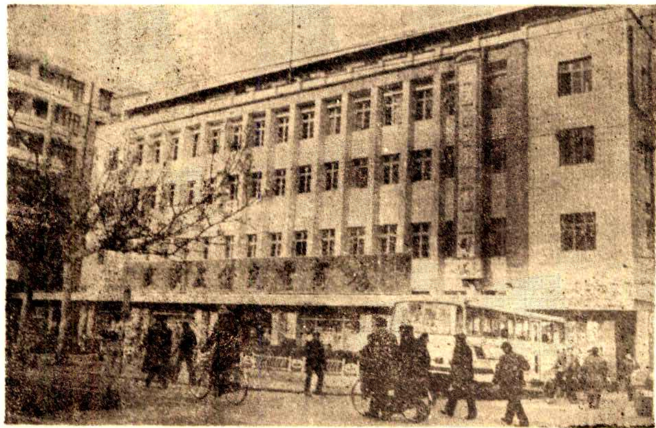
武汉市五金交电公司办公大楼
