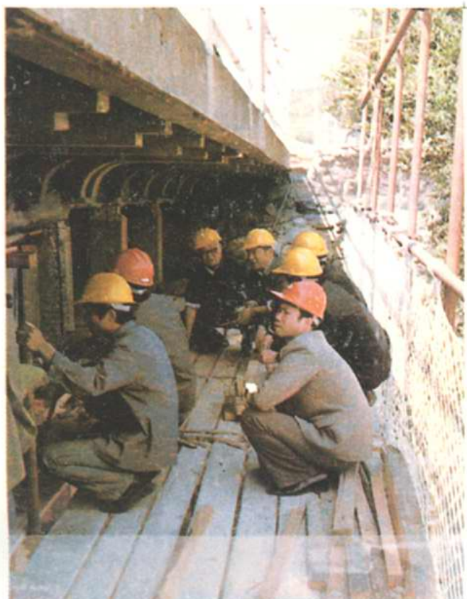
2—4—5 三家店大桥维修
