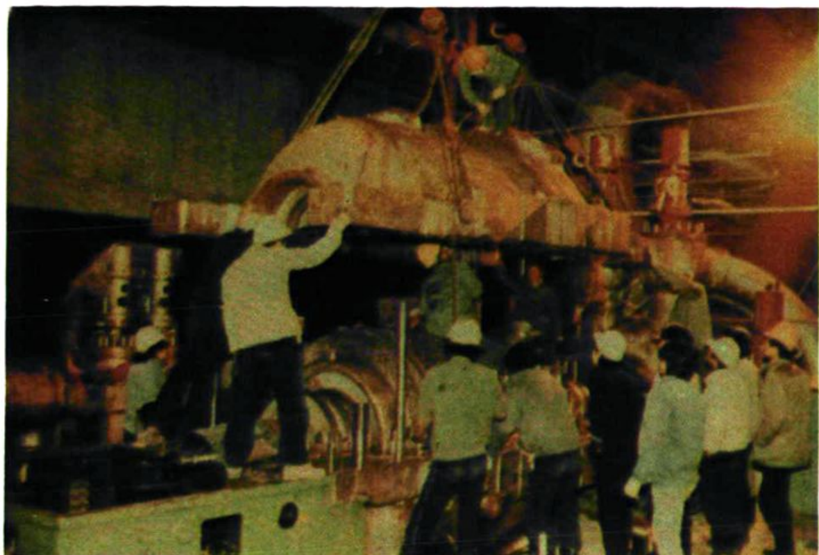
公司安装的浙江镇海电厂 20 万千瓦汽轮机扣盖前检查
