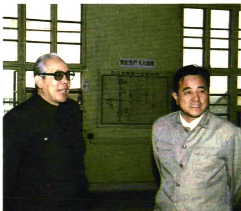
水利电力部副部长 赵庆夫(左)视察本公司 安装的马江变电站
