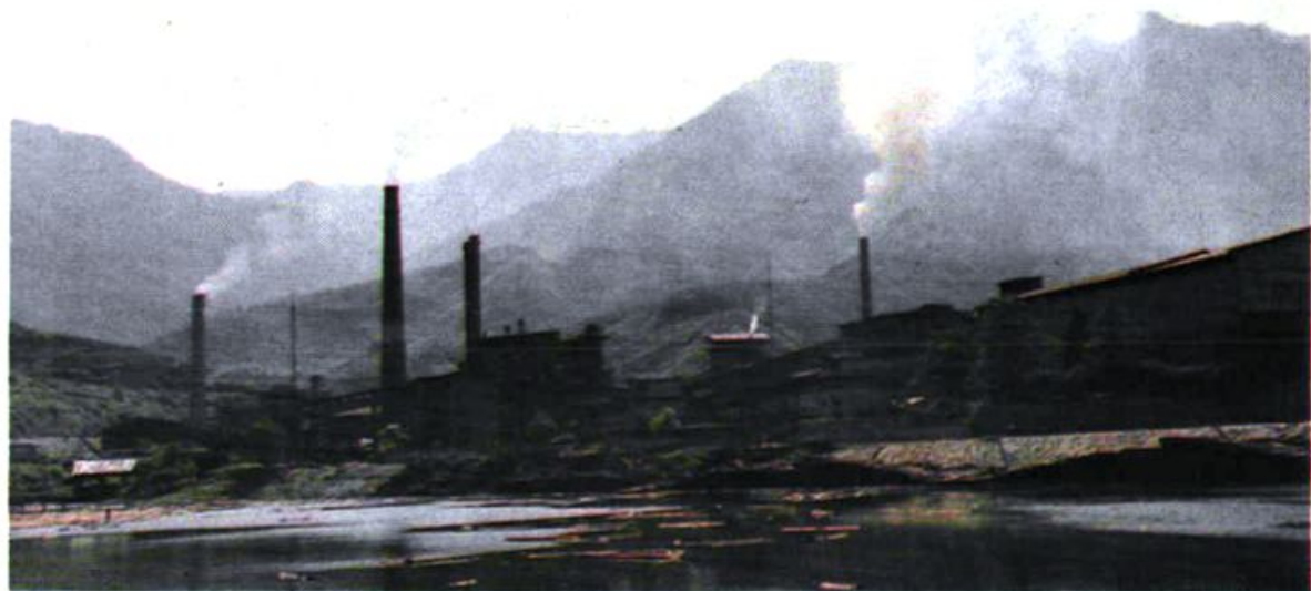
公司安装的第一台南平造纸厂动力车间 3000 千瓦机组
