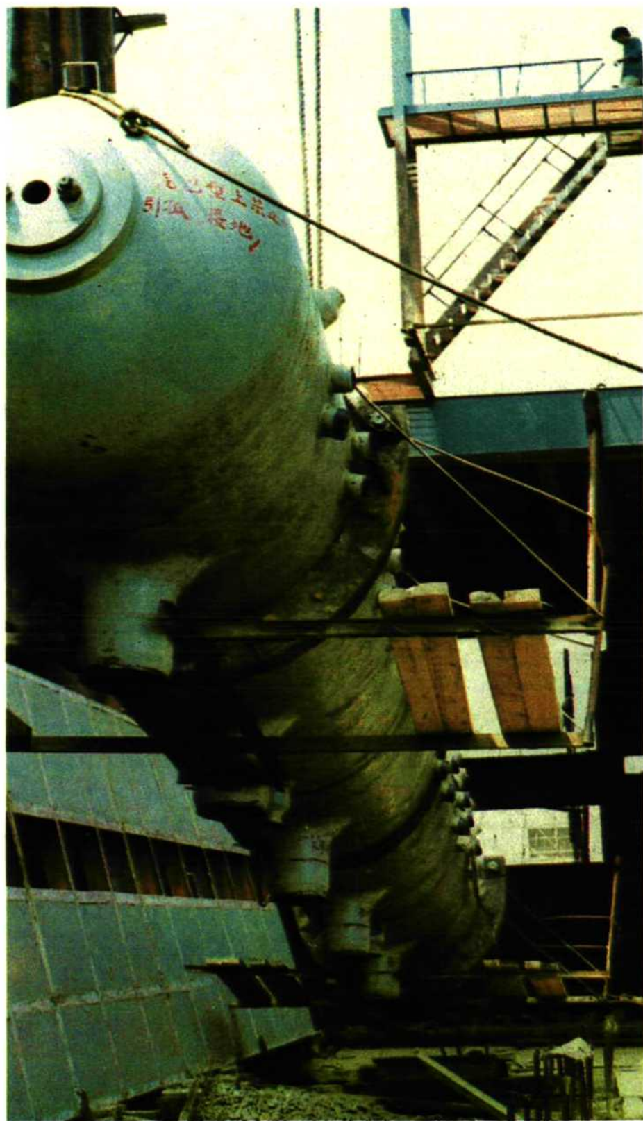
公司安装的永安火电厂锅炉大件起吊
