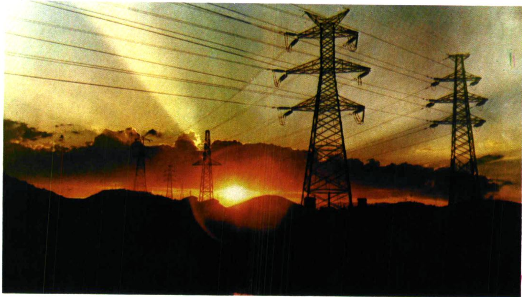
220 千伏永安至厦门输电线路
