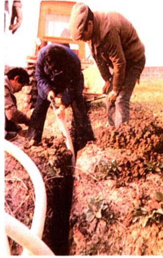
埋设地下暗管
