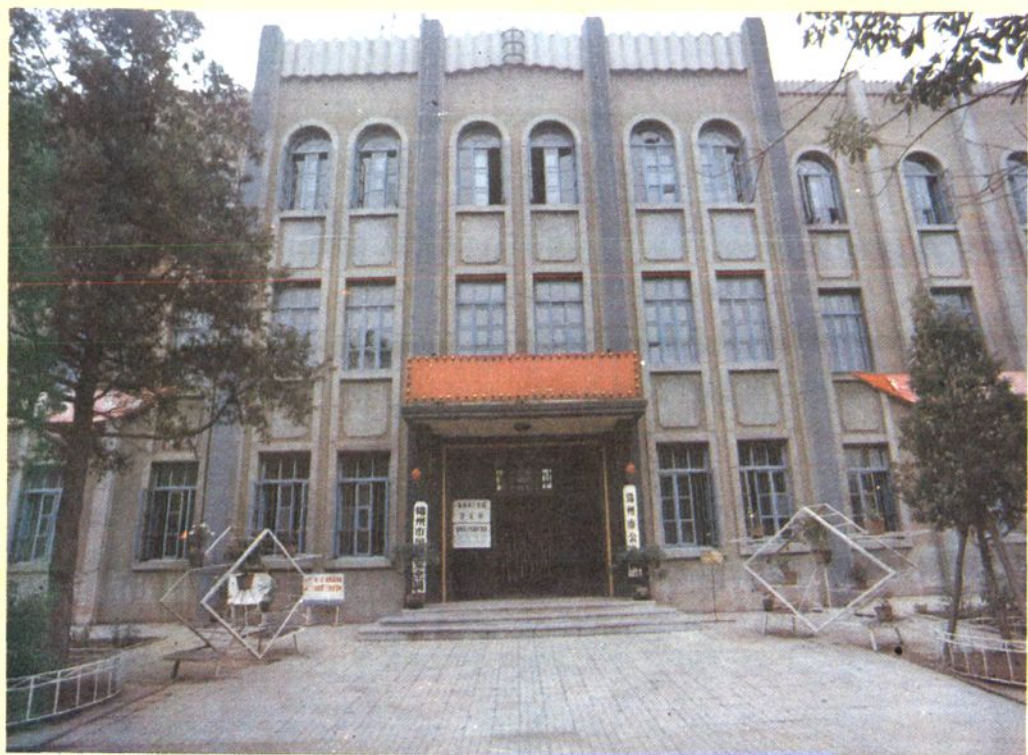
原辽西省分公司办公楼（锦州市古塔区丰乐街1号）
