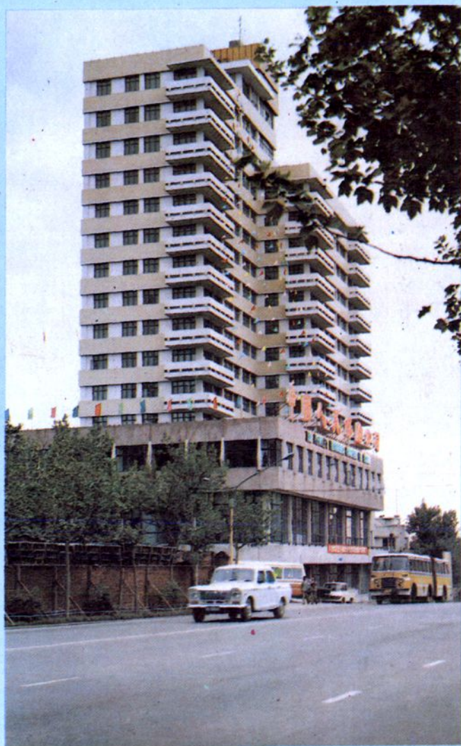
大连分公司办公楼 （1985年4月建成）
