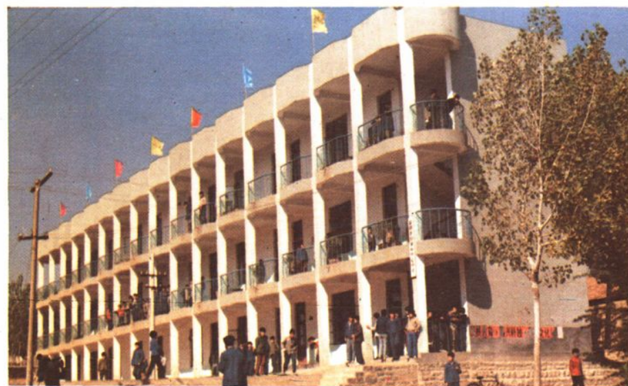
地处岸堤水库库区的旧寨乡群众集资兴建的中心中学教学楼
