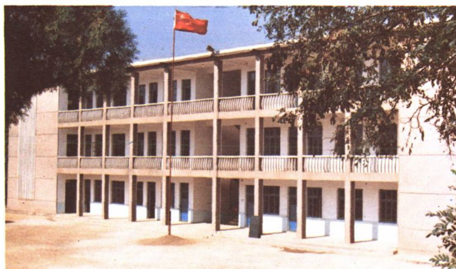
革命老根据地岱崮山区坡里镇中心中学教学楼
