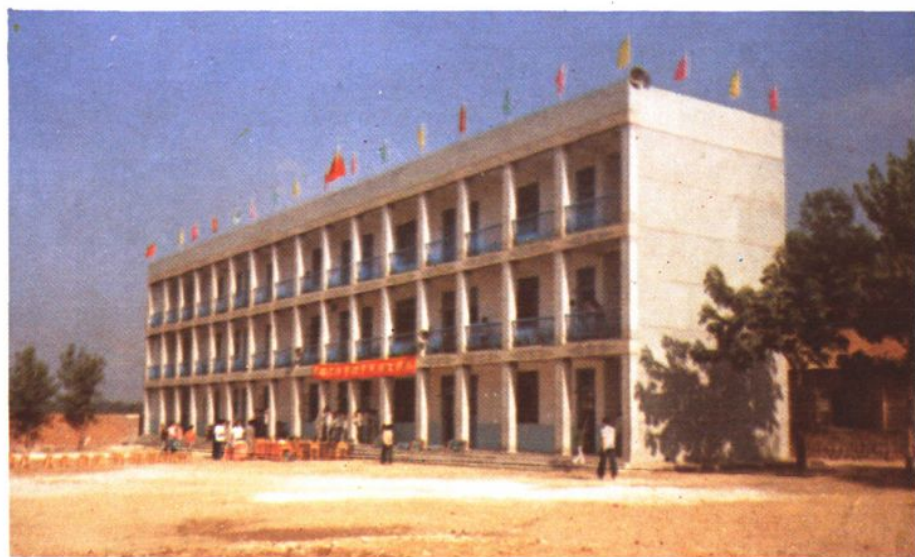
全县第一座由乡镇集资兴建的常路镇中心中学教学楼
