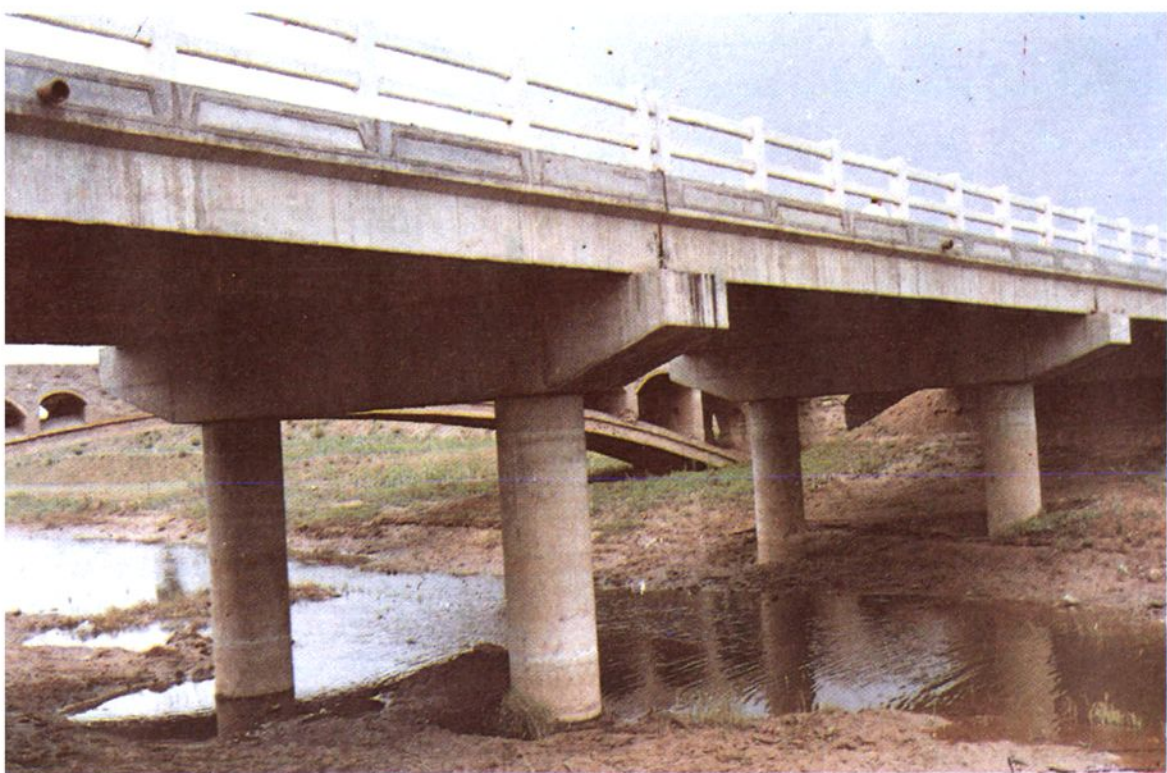
宏郭线文峪河大桥。
