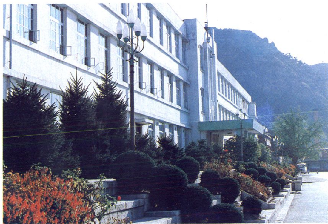
学校基础实验楼
