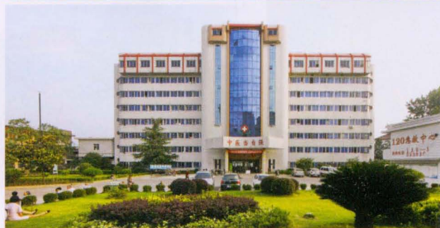
慈利县中医医院 住院大楼
