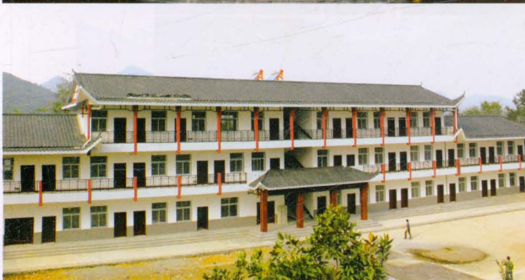
金岩土家族乡人民 政府综合办公楼
