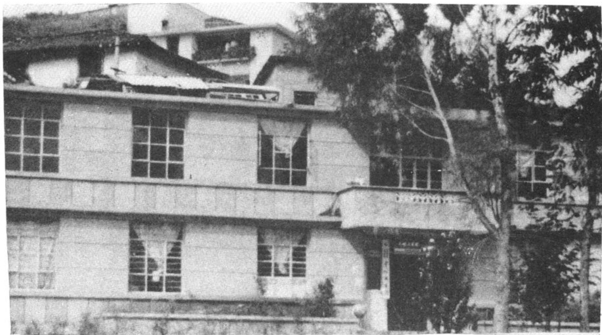
镇卫生院门诊、住院部
