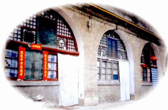
1950 — 1966年，位于延安市市场沟口的原地区检察分院办公窑洞。
