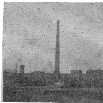
图三十、邓县砖瓦厂的轮窑烟囱
