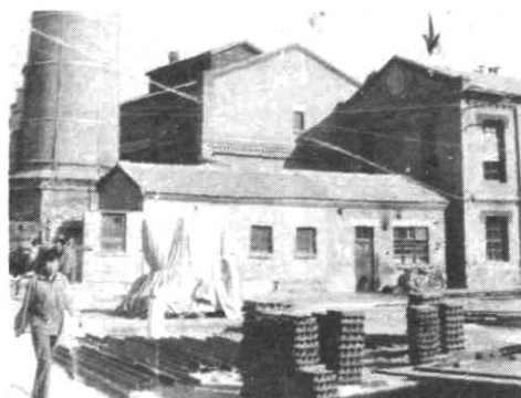
老厂 500、848、1000 千瓦发电机组厂房。
