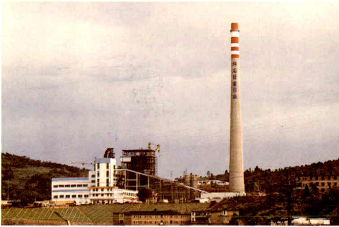
建设中的坪石火力发电B厂
