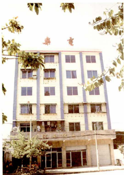
乐昌电力局河南供电所
