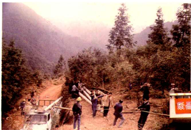
1995年2月，乐昌大源林区线路被大雪压断。图为抢修现场
