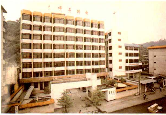
坪石供电局大楼
