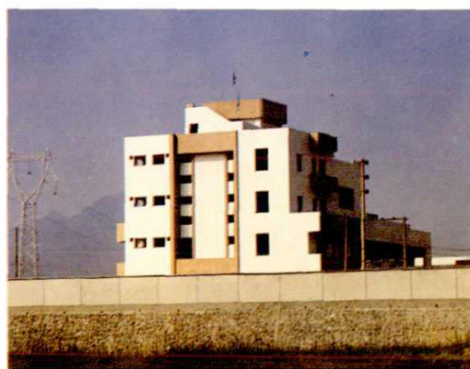
建设中的乐昌 220KV 变电站
