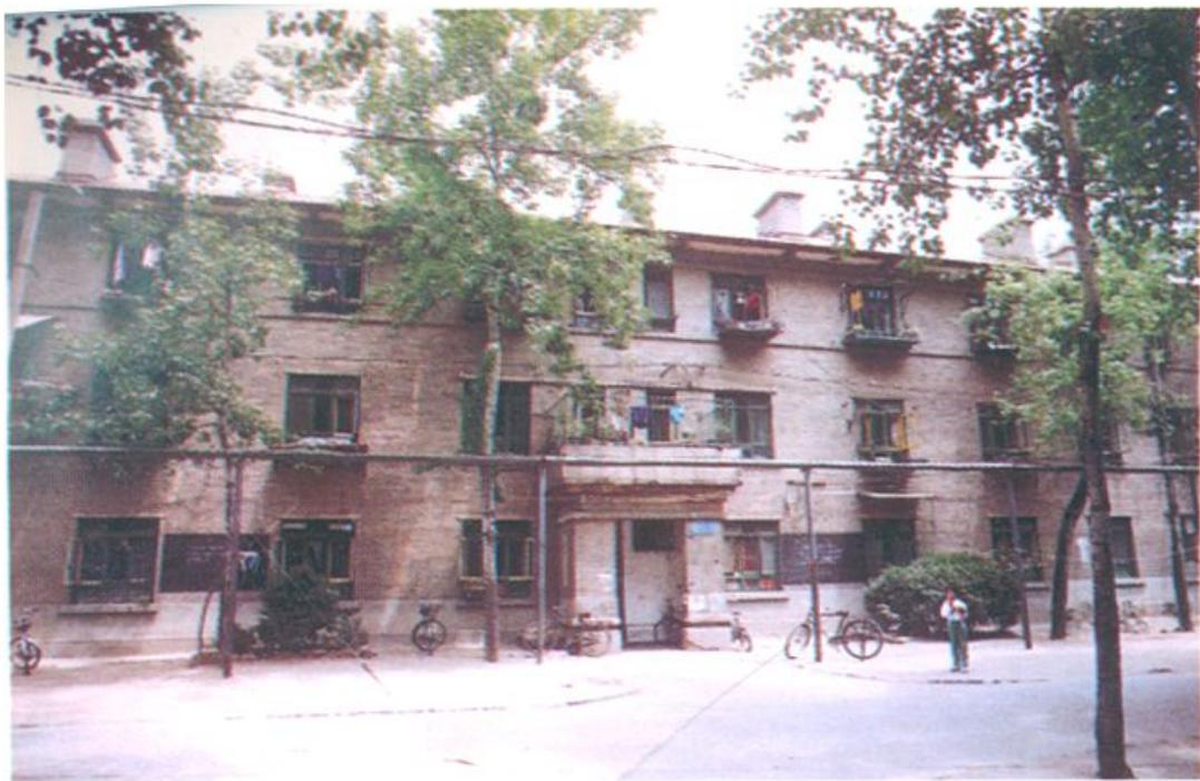
五五年建厂时建的住宅楼,现存 5 幢,10752.33 平方米,楼高 3 层,混合结构,2—3 家合用厨房,3—7 家合用厕所。
