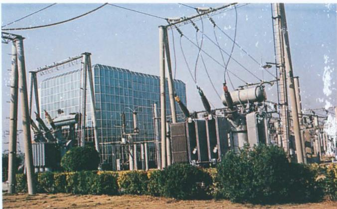
▲ 东山 110KV 变电站装机 4 万千伏安
