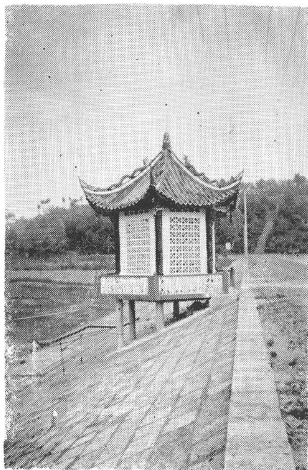
右低放水闸房
