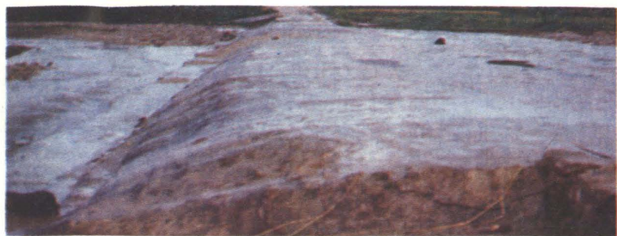
大沙过水路面
