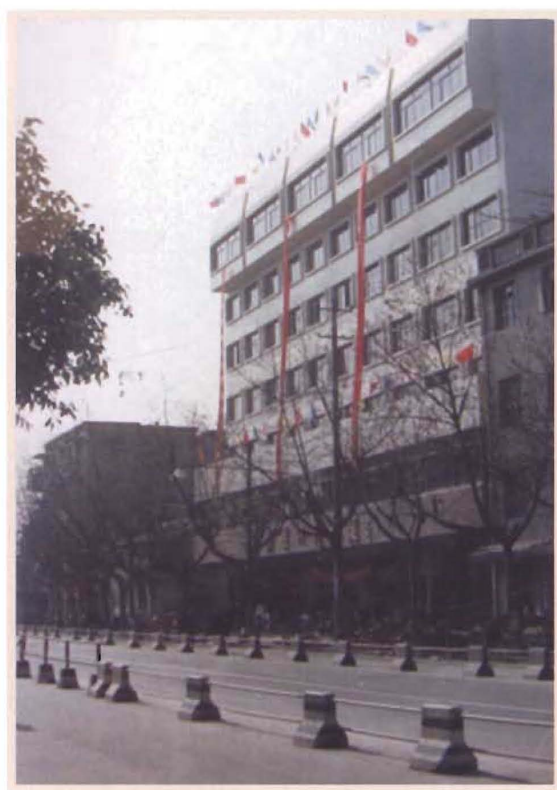
鄞县供销大厦全景
