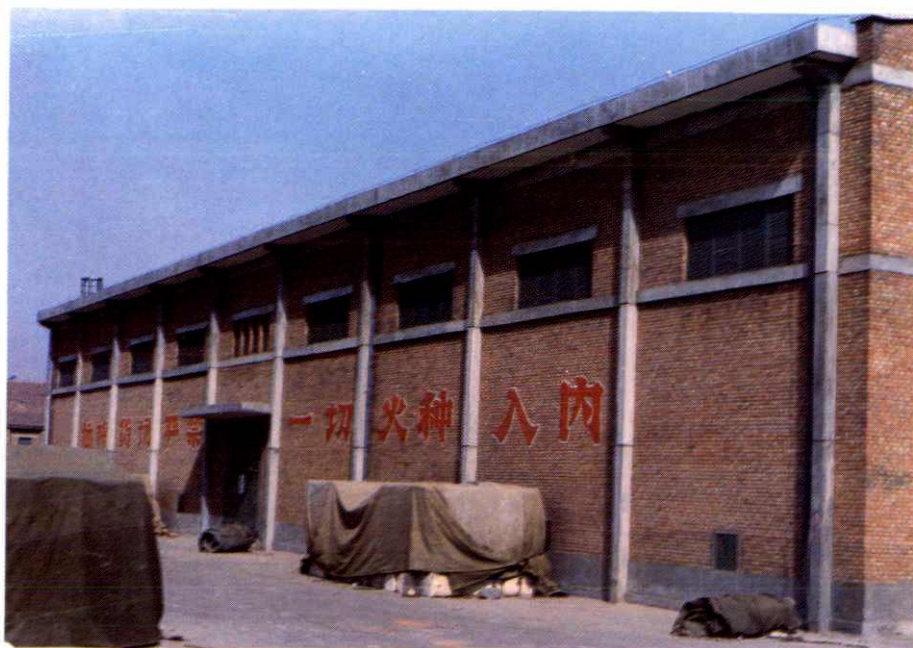
新建储备棉仓库
