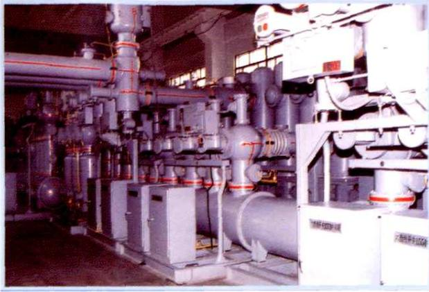
乌鲁木齐市城网改造工程中安装的六氟化硫组合电器(六道湾变电所)
