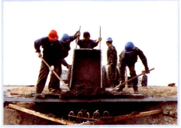
220 千伏托(托克逊)一油(油田变电所)线铁塔基础浇筑
