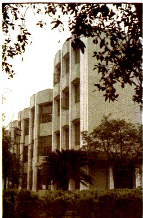
开县中学教学楼
