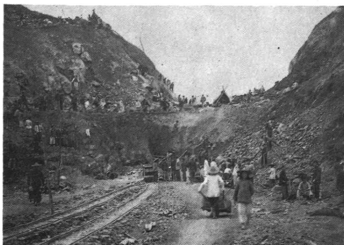
▲ 横锦水库溢洪道开挖
