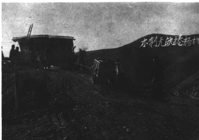
▲木制无轨卷扬机运土
