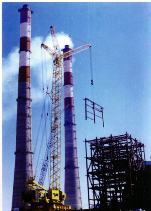
湖北省电力施工企业承建的巴基斯坦木扎法戈电站施工现场
