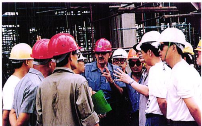
国外专家在鄂州电厂施工现场
