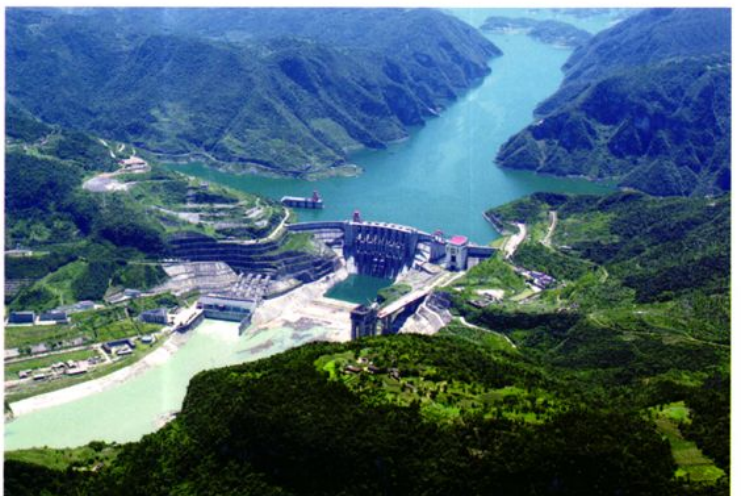
清江隔河岩水电站于1987年1月动工,至1994年11月4台机组全部投产发电,总容量121.2万千瓦
