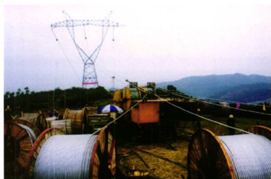
500千伏隔河岩—葛洲坝换流站输电线路是隔河岩水电站外送配套工程，于1993年6月动工，1994年5月竣工。该线路所经地域高山大岭地形占全线路的65%，施工及运输极其困难。图为该线路施工中
