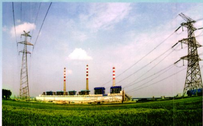
1996年11月，襄樊电厂一期4台机组同时动工，至1999年，4台机组全部投产发电。其中，1、4号机组创造同类工程建设的优秀业绩，实现达标投产。图为电厂远眺
