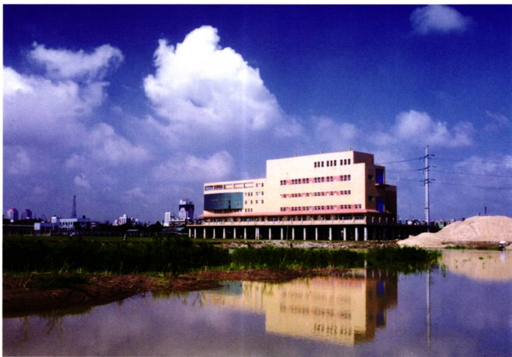
1999年，武汉市第一个户内式220千伏变电站——江滩变电站投产送电
