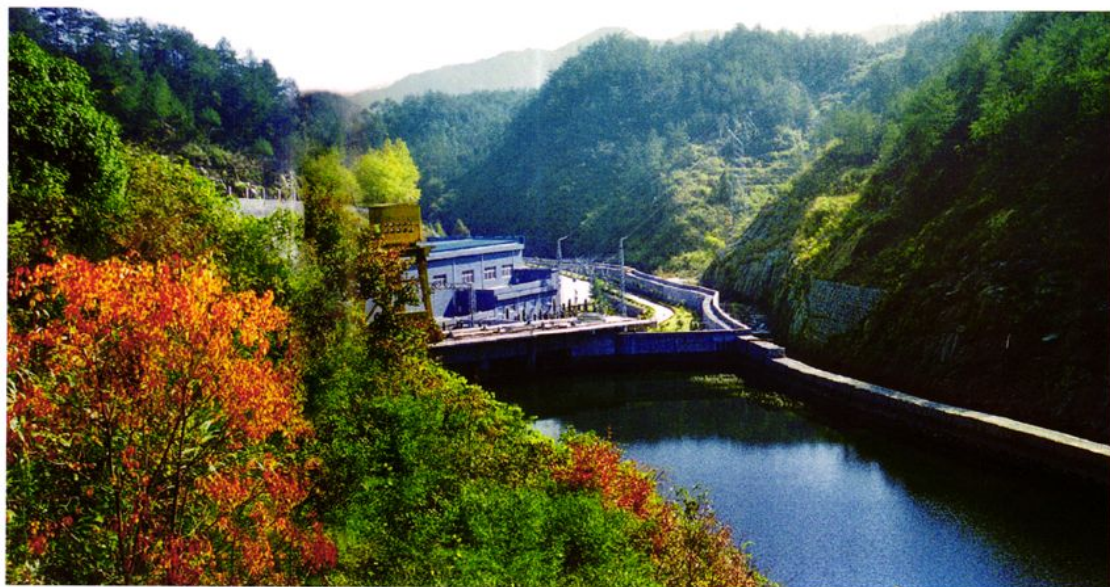
湖北省第一座抽水蓄能电站——天堂抽水蓄能电站于1998年开工，2001年5月正式投产，装机2台，总容量7万千瓦
