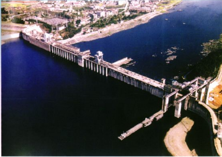
丹江口水电站于1973年10月全面竣工,共装机6台,总容量90万千瓦,1994~1996年先后进行部分机组增容改造
