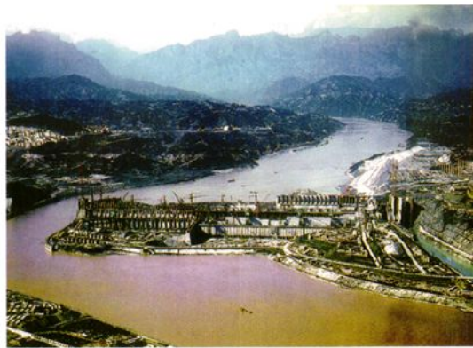
2001年底建设中的三峡工程全景
