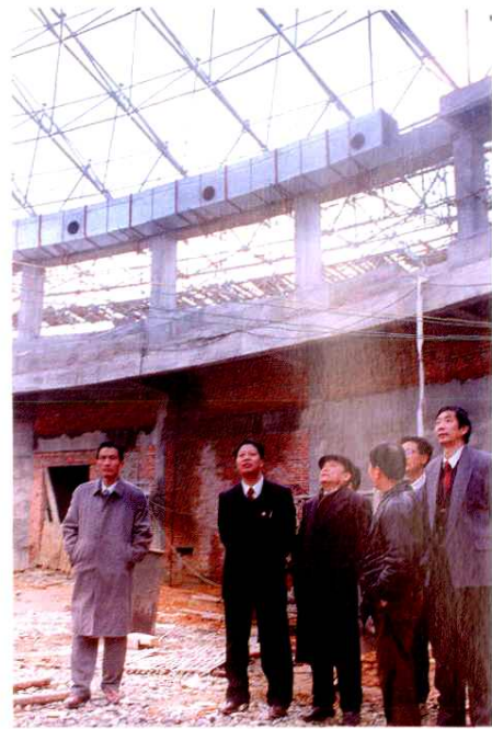
△越南驻华大使馆商务参赞阮文寿参观十运场馆建设。
