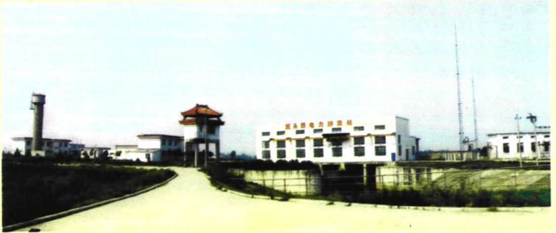
洲头西电力排涝站
