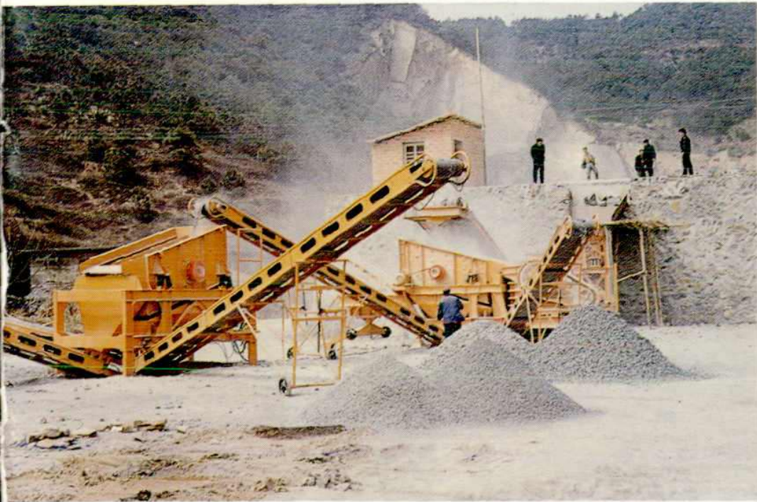
南昌公路分局新建县麦园石料场
