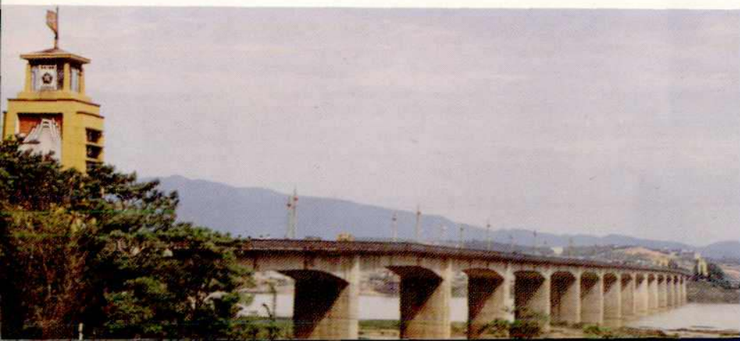
大跨径(21米)预应力 混凝土梁桥——吉安大桥
