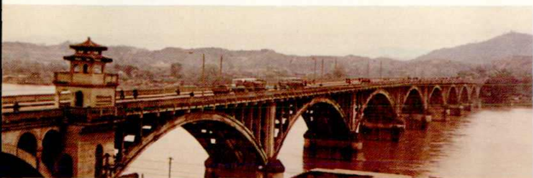
大跨径(80米)钢 筋混凝土肋拱桥—— 赣州东河大桥
