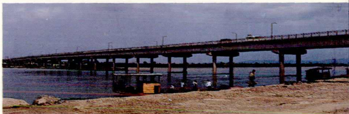
—— 抚州市抚河大桥 预应力混凝土梁桥
