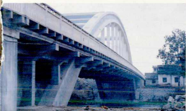
单孔跨径 80 米钢筋混凝土 中承式拱桥——大余县梅关大桥
