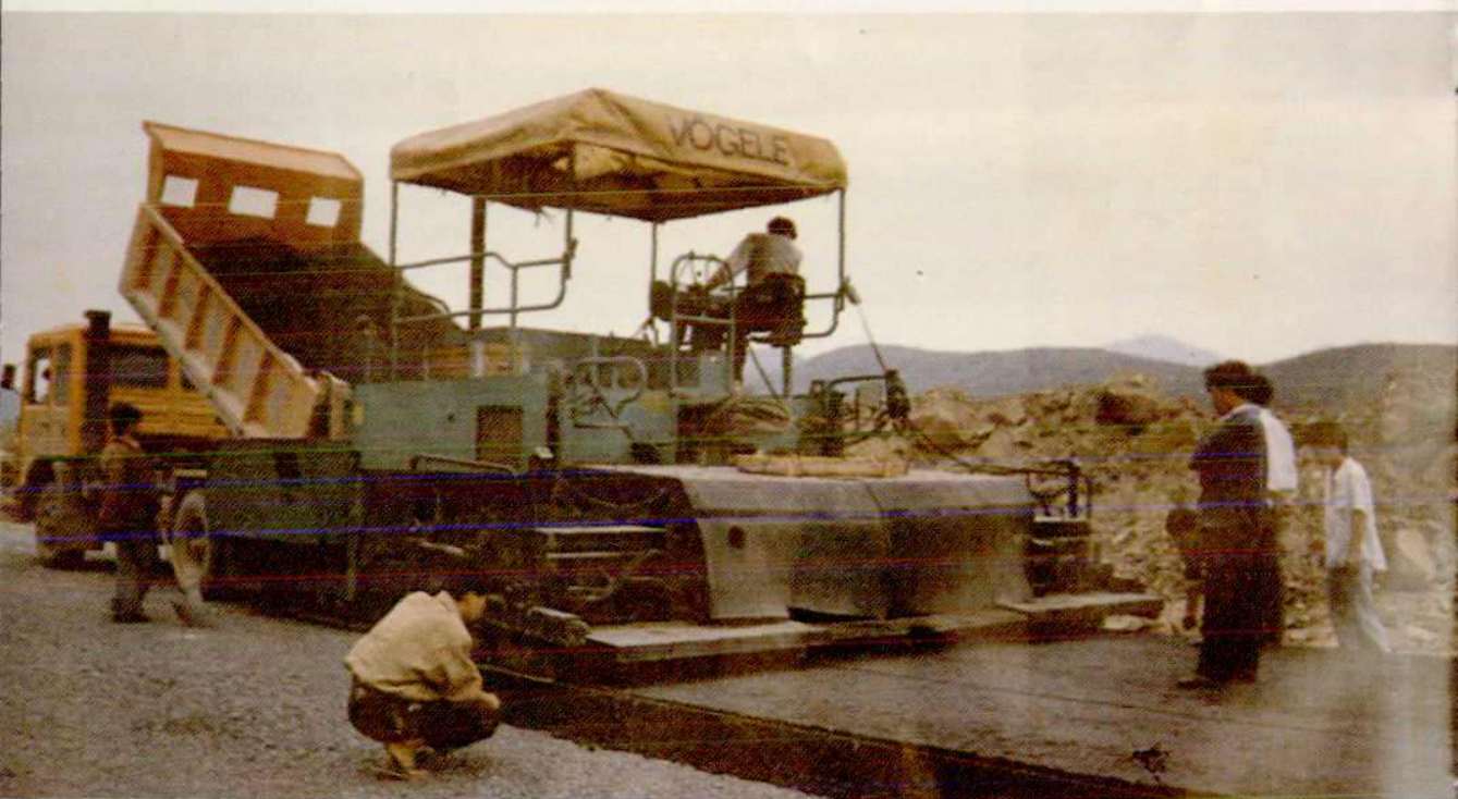
南昌——九江一级汽车专用公路路面摊铺及检测
