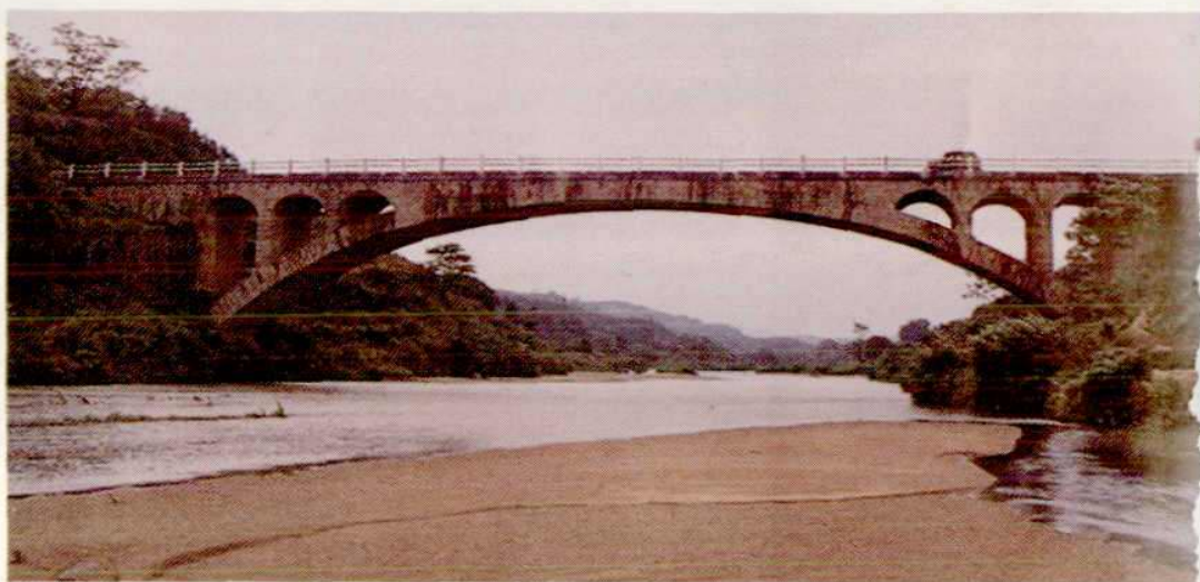
大跨径(80米)乱石(片石) 拱峡江县新江大桥
