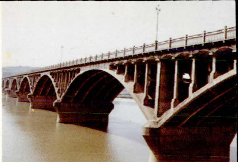
钢筋混凝土双曲拱 ——贵溪县信江大桥
