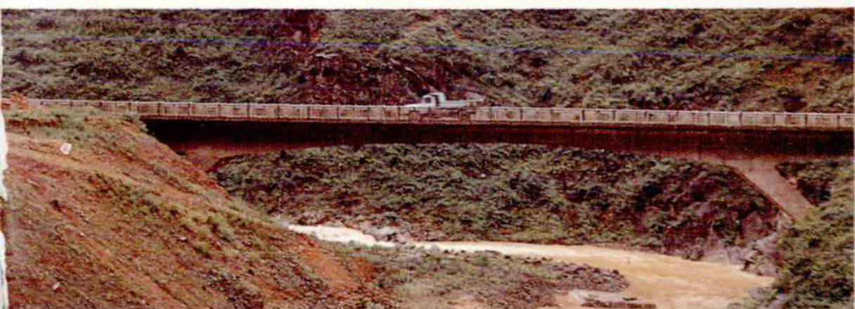
预应力混凝土斜腿刚 构——遂川县洪门大桥
