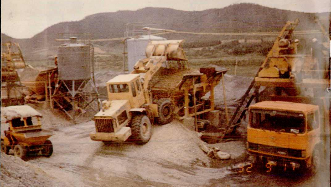
南昌——九江一级汽车专用公路乌石门段路面材料拌和场
