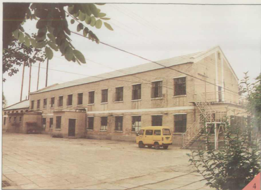
4. 新华社干部进修学院时期的教学楼(板井村)。
