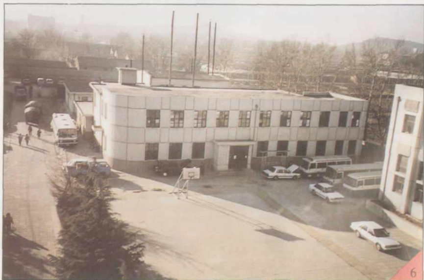
6. 学生食堂(正黄旗甲一号)。
