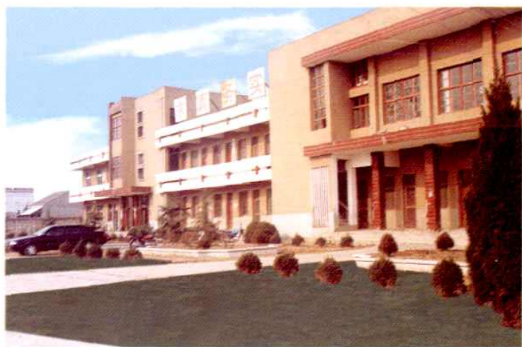
项桥乡政府办公楼
