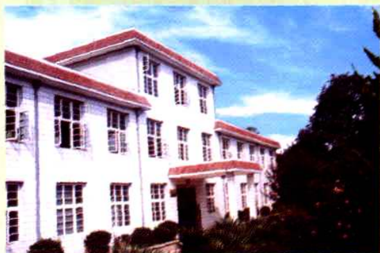
龙亢镇卫生院综合楼
